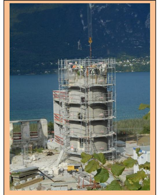
**3<sup>ème</sup> étape** : Construction de la dalle du second étage en béton armé sur des poutres en chêne qui constitueront le futur plafond à la française (Technique du coffrage perdu). Aucun mur porteur n'est prévu ce qui en fera la salle de réception la plus vaste de la région (330 m<sup>2</sup>).
