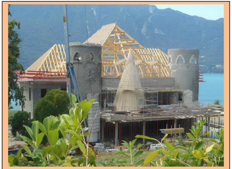
**6<sup>ème</sup> étape** : Couverture puis mise en place des 2 charpentes coniques avec l'aide d'une grue.
