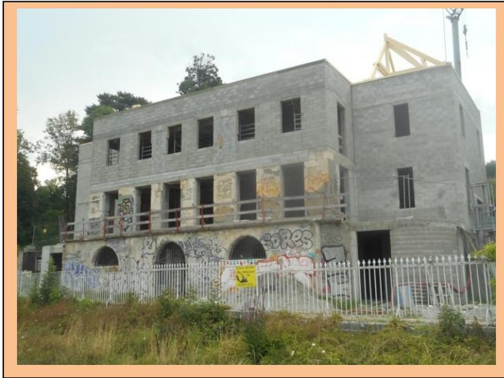
**5<sup>ème</sup> étape** : Assemblage de la charpente par des compagnons. Fabrication au sol des toits des 2 tours
