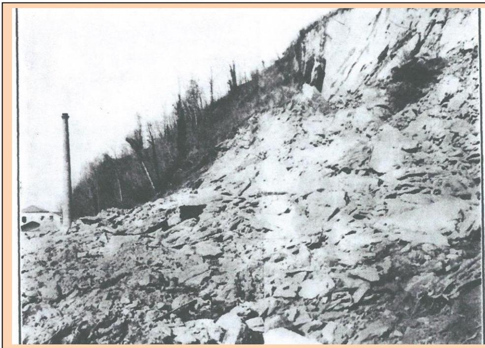
Des blocs énormes de schistes sont fichés en terre, retenus d'autres blocs qui s'accumulent les uns sur les autres dans l'éboulement mélangé à la boue. La grande cheminée de la blanchisserie est maculée de traces de limon qui durent jaillir pendant l'effondrement.
