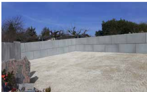
Extension du cimetière en cours
